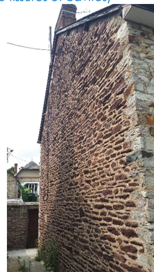
Murs en bon état (absence de fissures et cavités)
